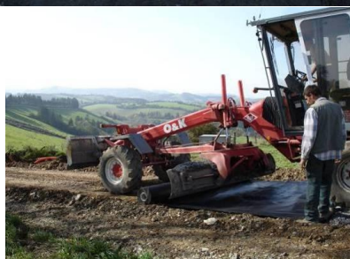
Pose du géotextile
