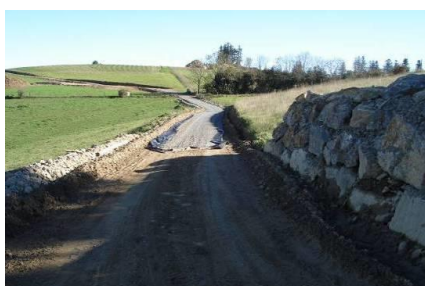
Mise en place du gravier
