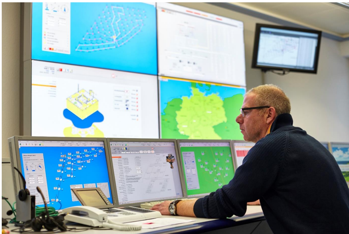
Conduite opérationnelle des installations de production au sein du Centre d'Exploitation de Barhöft
